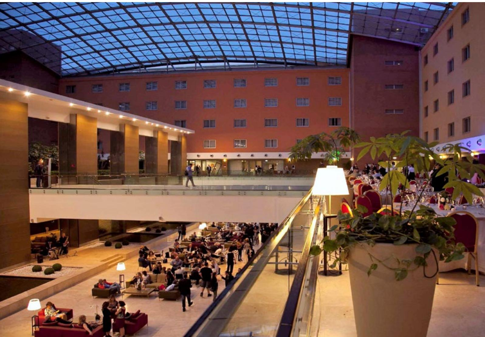
transmettent les poussées horizontales aux appuis à travers des supports coulissants. Compte tenu de l'impossibilité de pré-assembler les panneaux courbes en verre incassable au sol, puis de les soulever à l'aide d'une grue, l'installation a été réalisée directement sur site.
