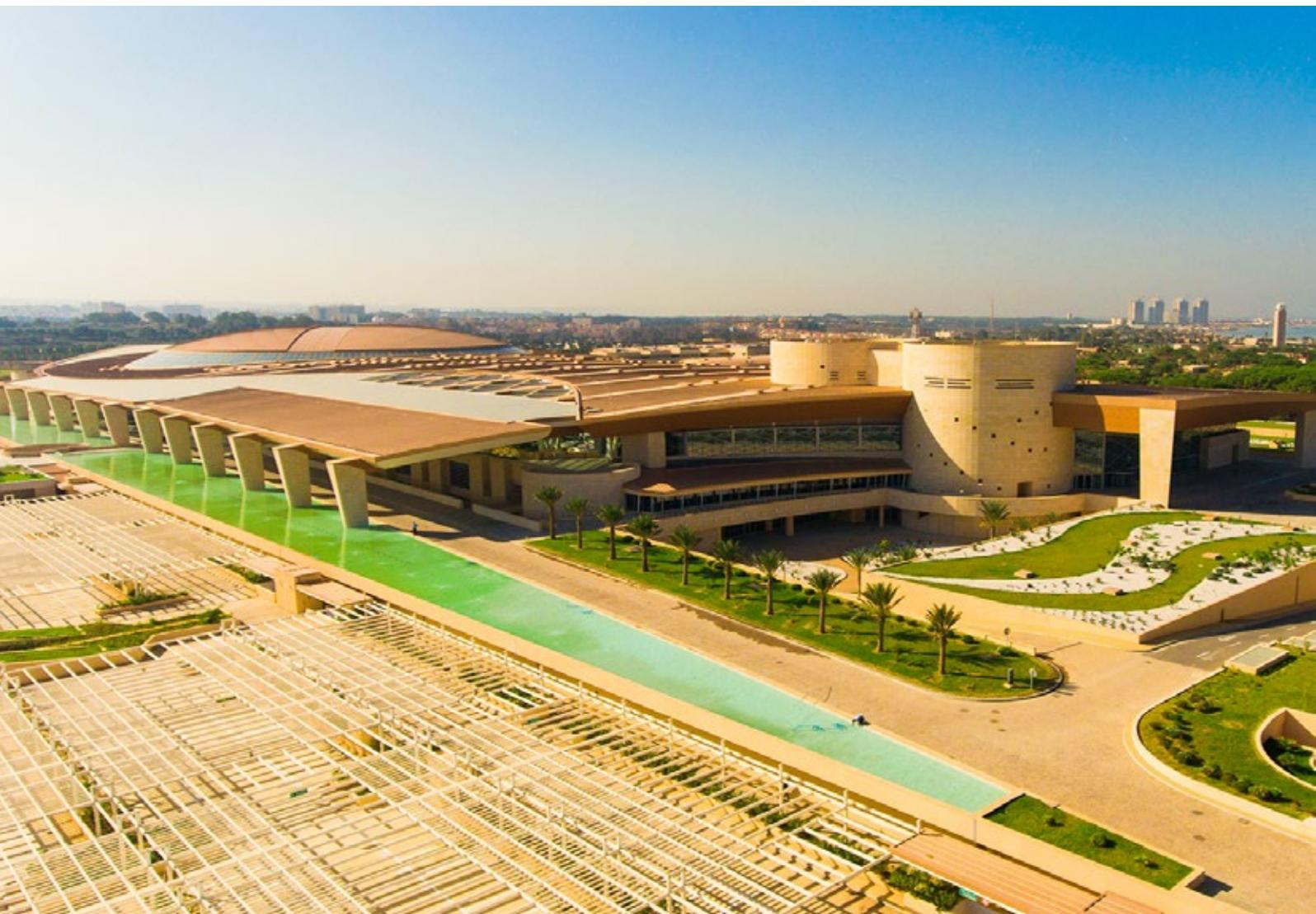
des poutres en treillis composées de tubes atteignant 6 mètres de hauteur. Les couvertures T1 et T2, de 150 mètres de large, sont reliées à la couverture T5, la plus grande de la structure, qui se développe sur 330 mètres.
