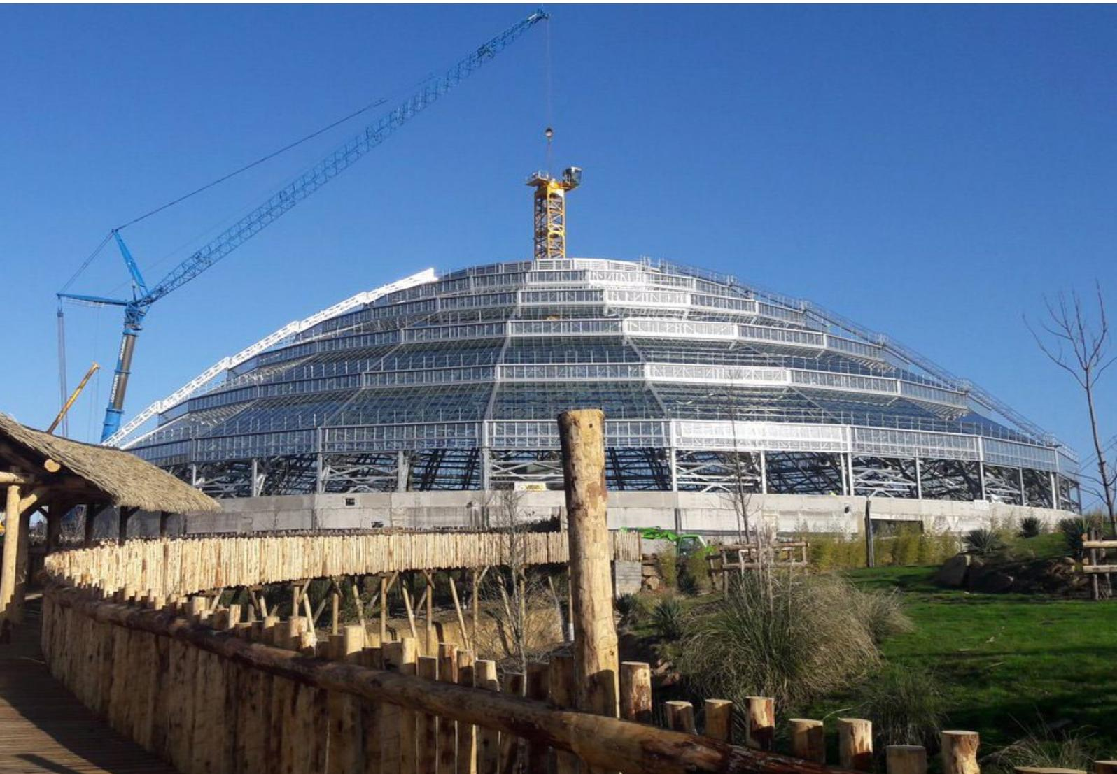
le dôme sera entièrement recouvert de verre, équipé d'un système de régulation de la lumière, de la température et de la qualité de l'air créant ainsi un écosystème tropical qui
